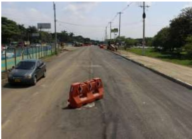
El tramo 3 de la obra es el más avanzado y en este la vía ya está pavimentada en 740 metros. Foto: Bernardo Peña | El País
