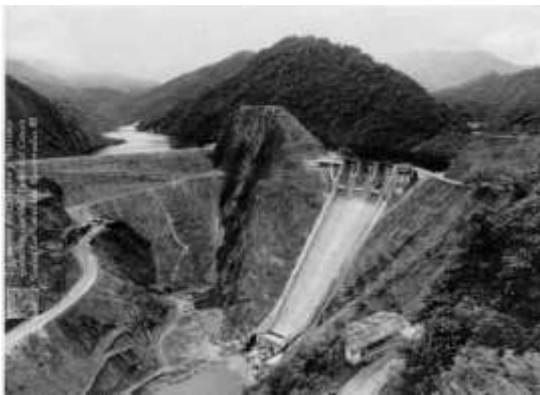
Imágenes de la construcción de la Central Hidroeléctrica del río Anchicayá. 1955
